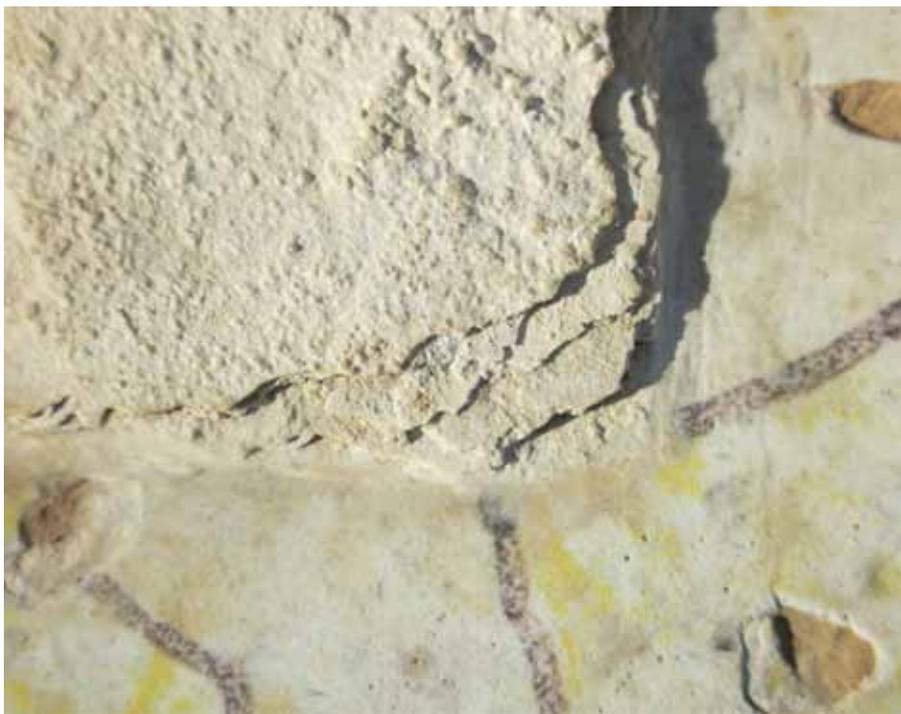
**Fig. 43.** Imagen del aspecto de la biocostra en el solado de uno de los estanques, se puede ver claramente el gran número de capas de que está compuesta.
