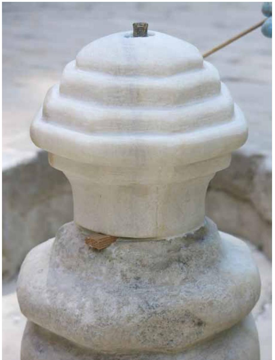
Figs. 60, 61, 62. Detalles del proceso de tallado y reproducción de la pieza correspondiente al tercio superior del surtidor copiado del surtidor original de la Fuente 3.
