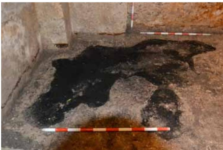
Figura 29. Detalle de la ruptura en el pavimento dejando al descubierto la capa de ceniza de su preparación.
