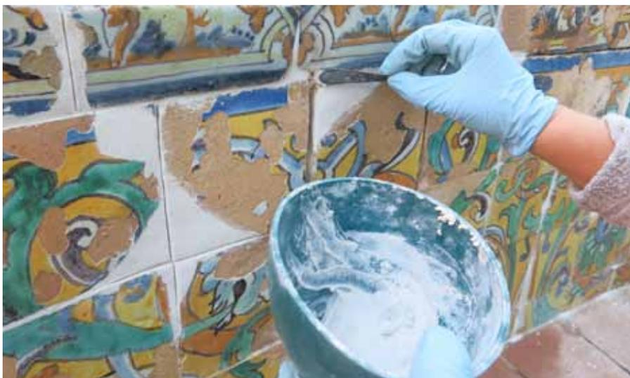
Fig. 57. Proceso de reintegración de las pérdidas de pasta en los bancos.
