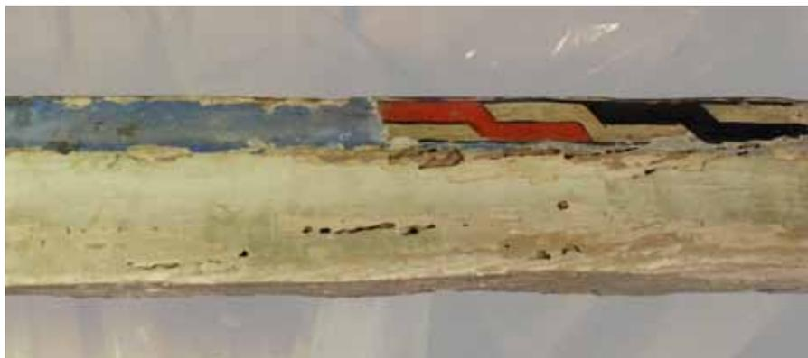
**Ilustración 4.** Durante el proceso de eliminación del repinte azul de mediados del siglo XIX para la recuperación del motivo mudéjar original en el madero del alicer del arco.
