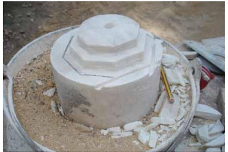
En la reconstrucción de la pieza se ha empleado mármol de características similares al original. El tallado de la pieza ha copiado los volúmenes que se conservan de la Fuente 3 aunque no se han querido reproducir los daños por erosiones o pérdidas de soporte para no inducir a errores. La pieza nueva posee aristas no demasiado angulosas para integrarse en el original.
