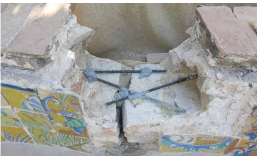
Figs.55 y 56. Imágenes donde se pueden observar las profundas grietas provocadas por los movimientos del terreno en varias zonas de los bancos. Detalle del cosido de los bancos con varillas de fibra de vidrio.
