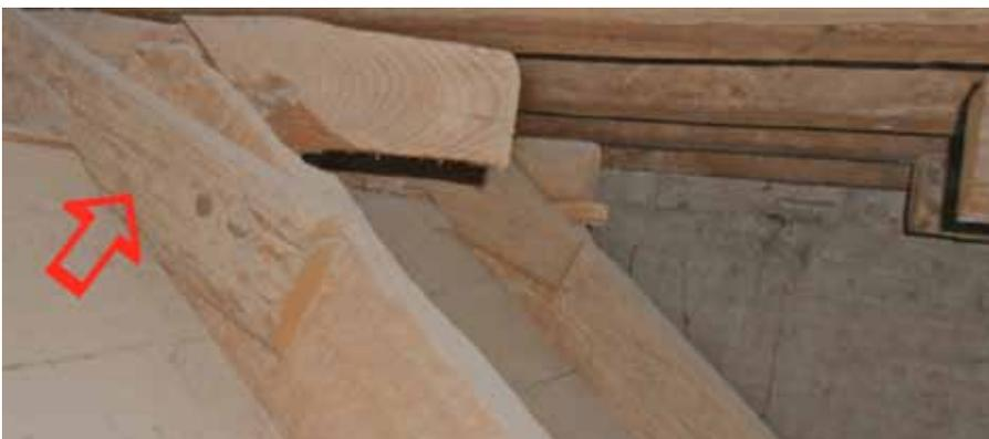
Ilustración 3. Detalle de la unión a horquilla y traba (señalada con flecha roja) entre faldón y almazate.
