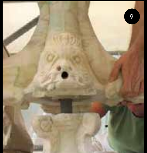
Figura 21. Proceso de montaje y recolocación de los elementos de la fuente: montaje del fuste en su base, reubicación de la pila y la urna y finaliza el montaje de los elementos de mármol con la colocación del grupo de delfines.
