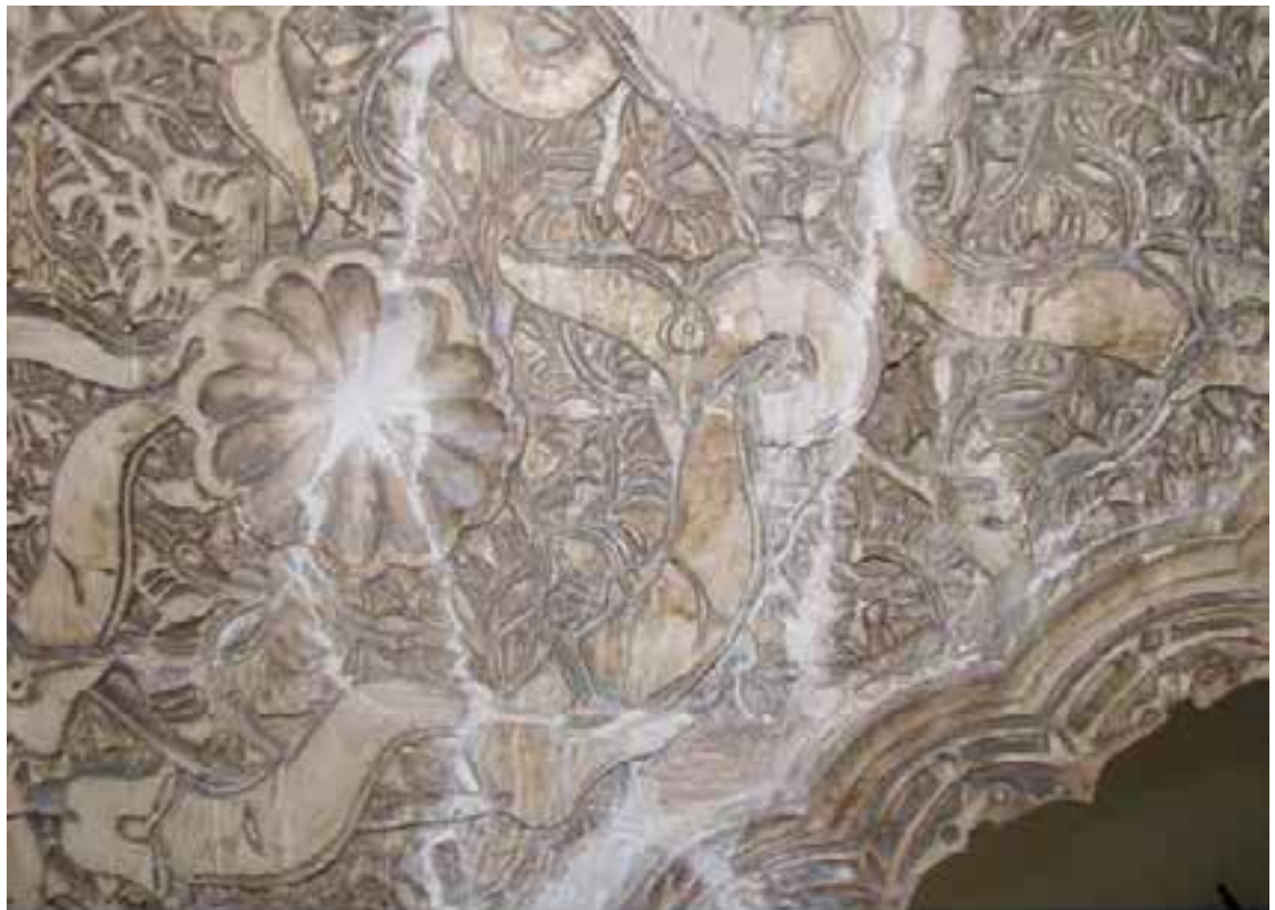
Figura 22. Adhesión de fragmentos y sellado de uniones y oquedades.
