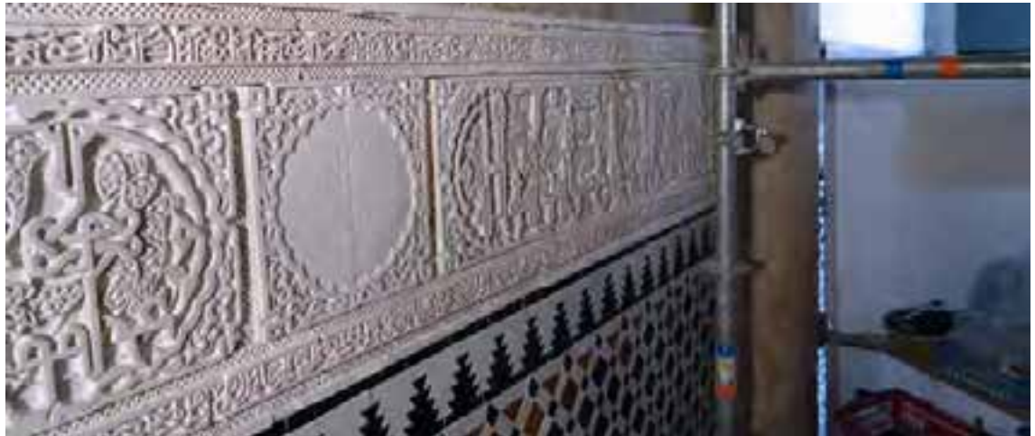
Imagen nº 31. Una vez terminada la colocación de la yesería, en la pestaña superior se dio una capa de resina epoxi y arena para que la aplicación del mortero de la pared tuviese una superficie de agarre más idónea
