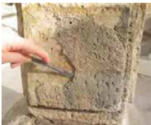
Figura 14. Limpieza de capas de costras y concreciones en diferentes zonas de la fuente.
