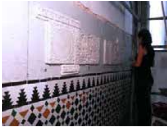
Imagen nº 29 Colocación de las placas de yesería
