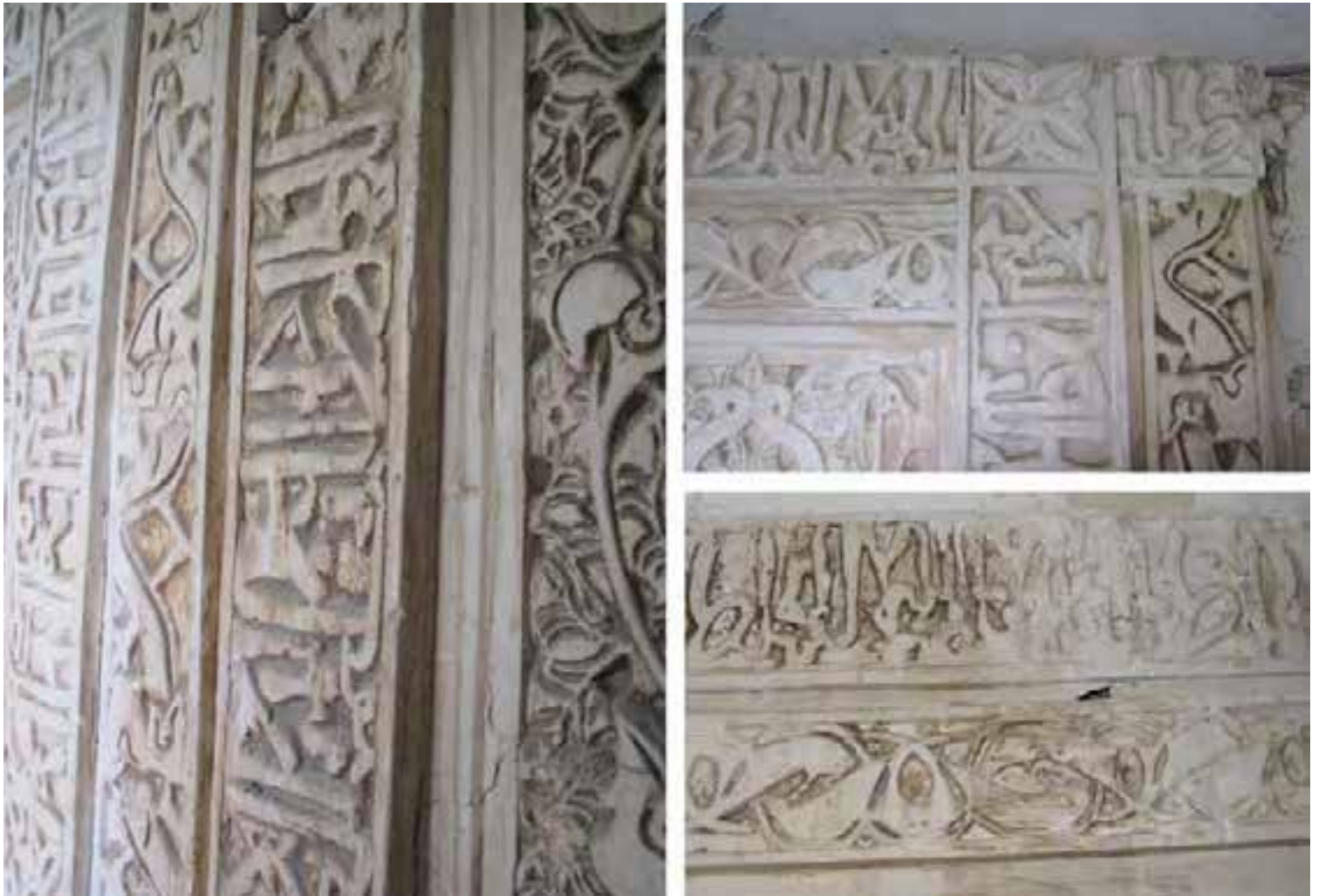
Figura 12. Detalles de diferentes tramos de alfiles donde se agrupan piezas cuyos tratamientos no están unificados, mostrando zonas muy destacadas tanto en la tonalidad como en los efectos del propio envejecimiento y degradación de los diferentes materiales y cubriciones empleadas.
