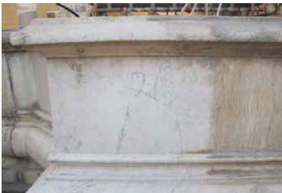
Figura 17. Proceso de limpieza de los estratos de concreciones en zonas del estanque por proyección de microesferas de vidrio.
