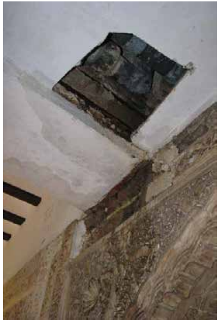
Figura 14. Localización del arco afectado. La imagen muestra las manchas de humedad por saturación en la viga superior, la que oculta el bajante causante de la incidencia.
