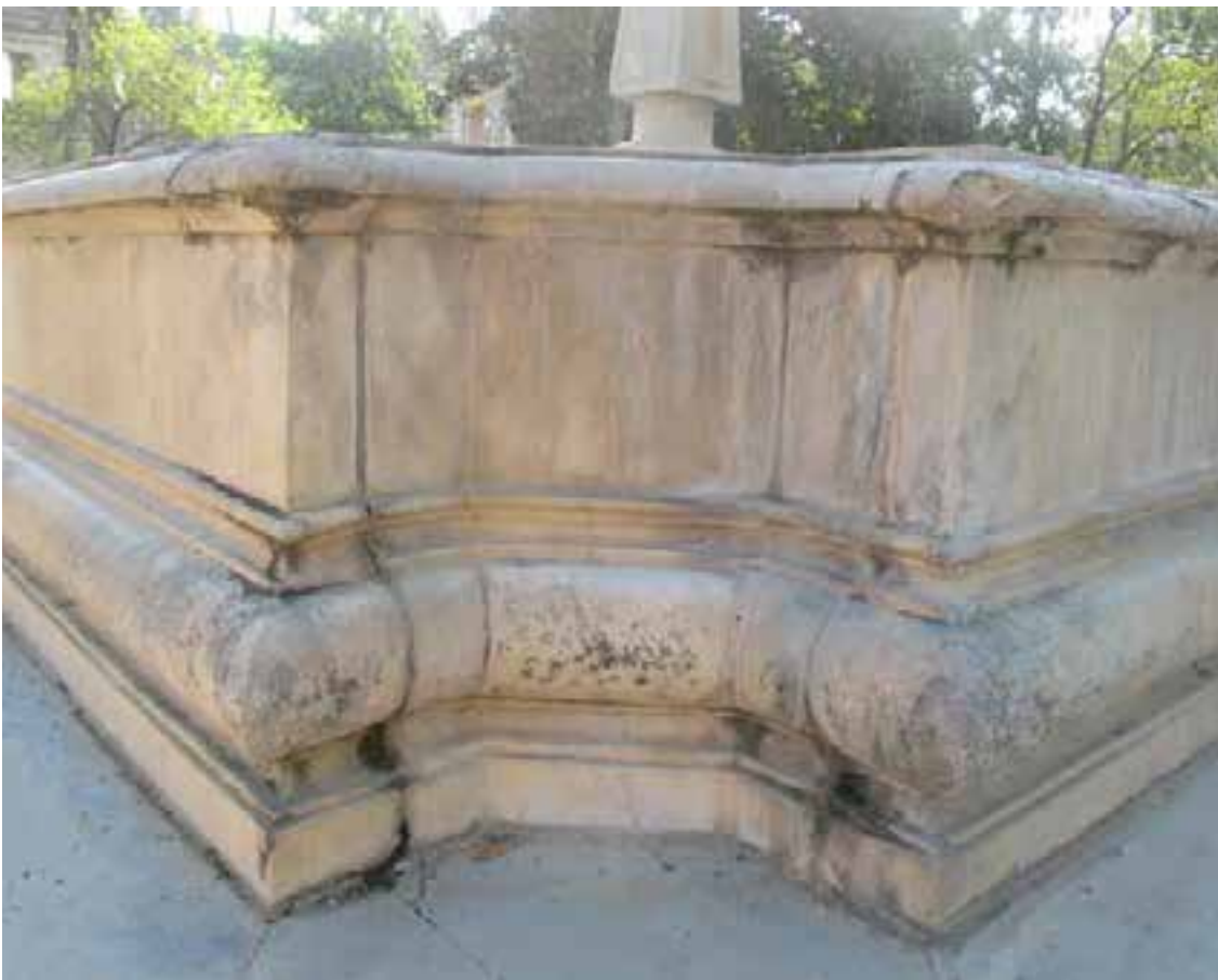
Figura 7. A la izquierda, daños de tipo químico por la formación de gruesos estratos de concreciones de tipo salino que recubren la superficie del soporte marmóreo
