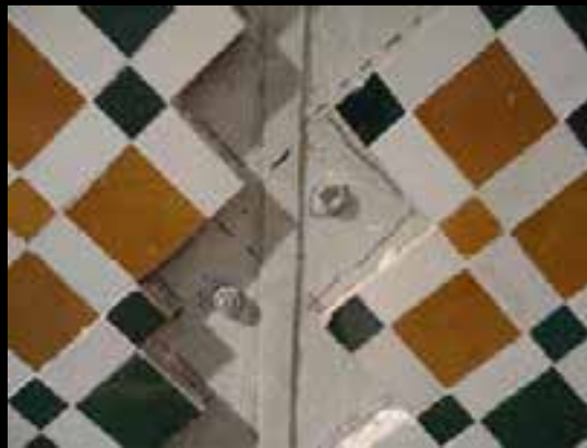
Imagen nº 25. Colocación definitiva de los paneles. Se puede observar como los encuentros entre ellos aun permanecen descubiertos
