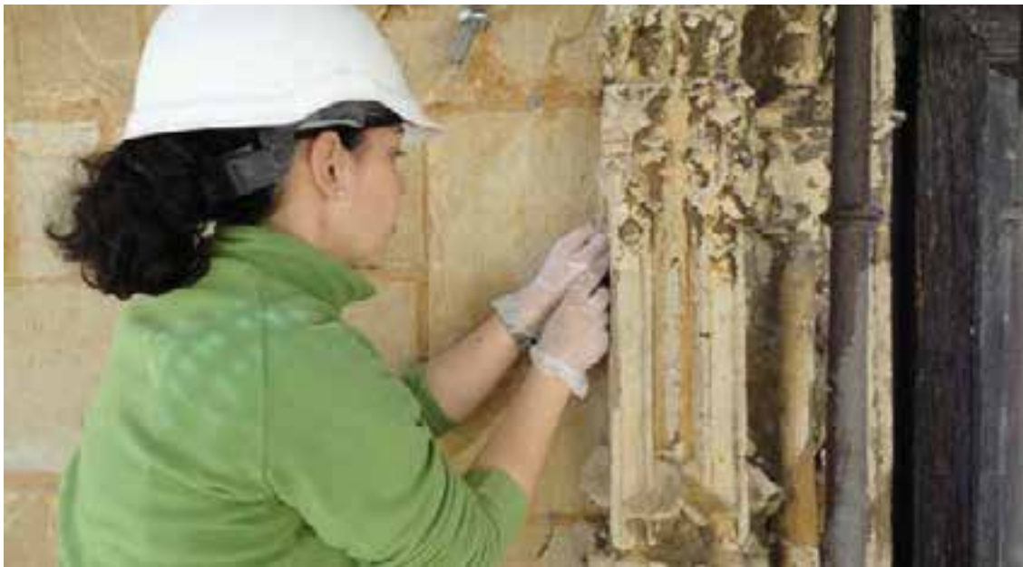
Figura 34. Cuidadosa limpieza manual de la piedra realizada con criterios de perfección, pulcritud y precisión.
