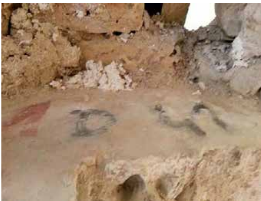
Figura 9 (izqu). Identificación de sillar con letras y números para el traslado de Marchena a Sevilla.
