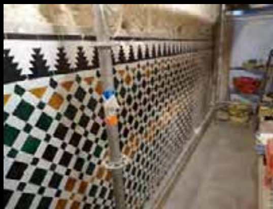
Imagen nº 27 Colocando las piezas entre los encuentros de los paneles
