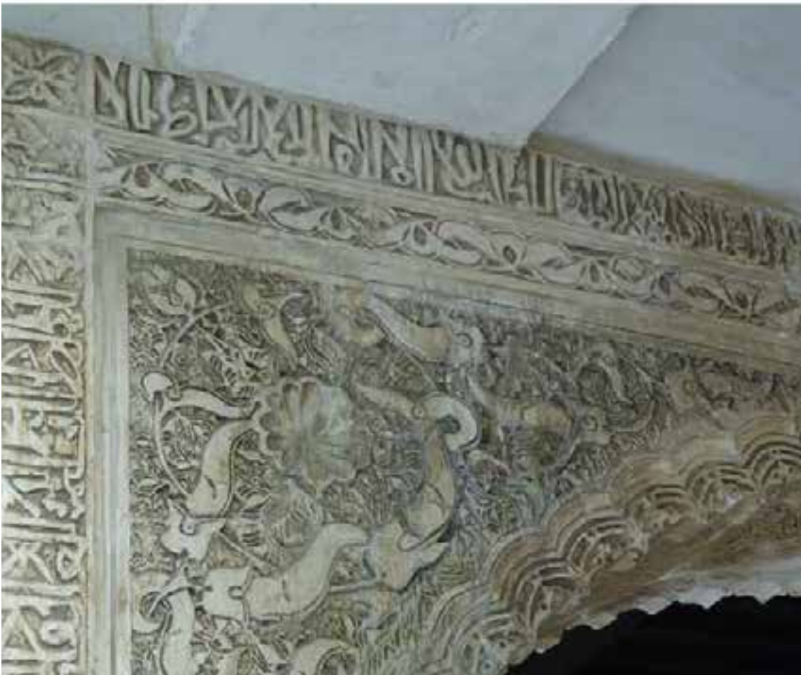
Figura 23. Restitución de piezas del alfiz, y sellados de uniones y oquedades. Posterior entonación final con acuarelas. Resultado final
