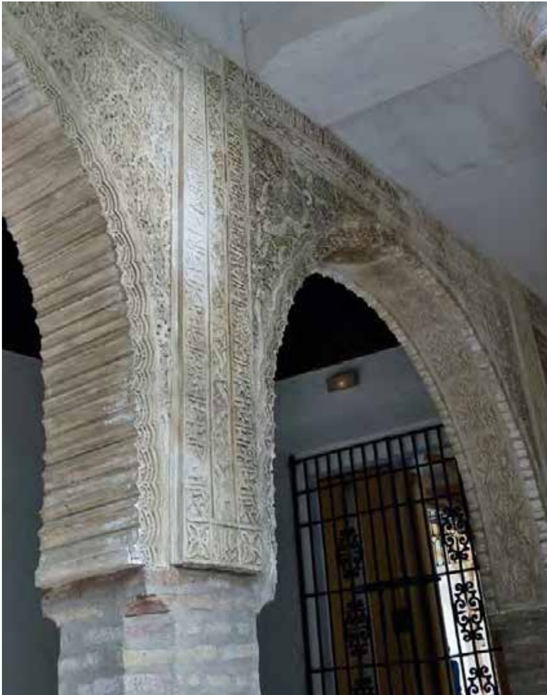
Figura 24. Resultado final de la intervención.
