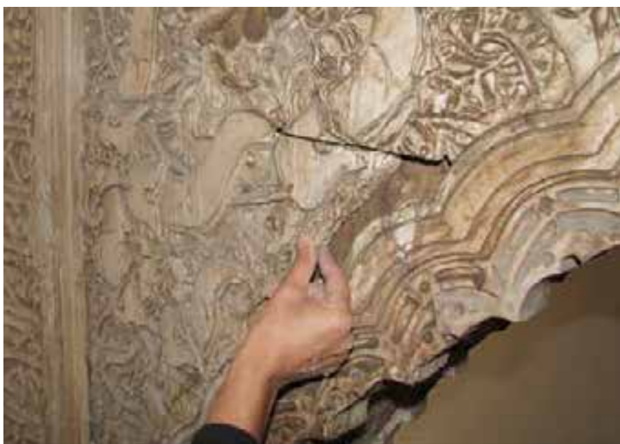
Figura 16. Desmontaje controlado de los fragmentos con alto riesgo de desplome.
