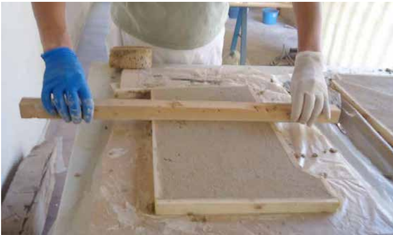
Imagen nº 14. Nivelación de mortero en uno de los fragmentos
