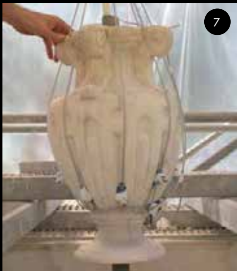
Figura 21. Proceso de montaje y recolocación de los elementos de la fuente: montaje del fuste en su base, reubicación de la pila y la urna y finaliza el montaje de los elementos de mármol con la colocación del grupo de delfines.
