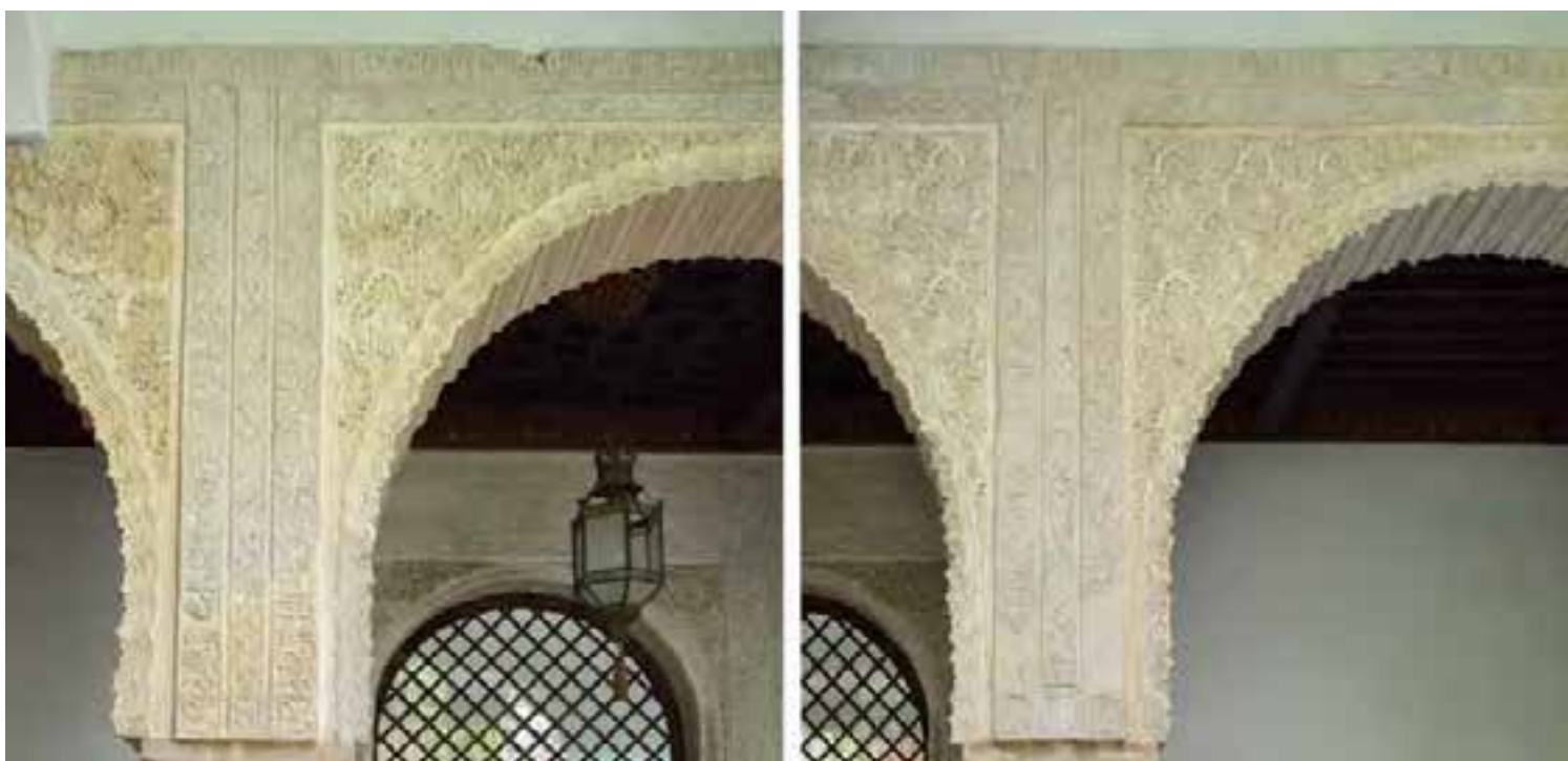
Figura 11. Piezas de los alfices centrales del lado norte con una tonalidad agrisada y fría respecto a las albanegas. Se estima que responden a piezas antiguas, tal vez primitivas.
