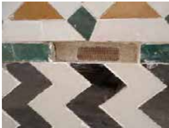
Imagen nº 32 Detalle de la rejilla de ventilación antes de colocar la pieza que la cubre
