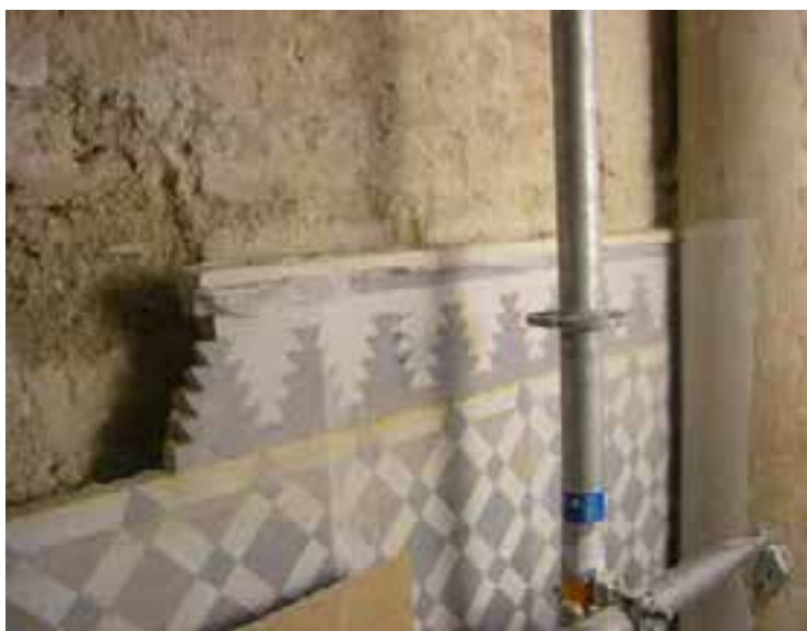
Imagen nº 6. Protección previa al desmontaje
