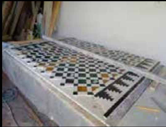
Imagen nº 23. Pegado de los fragmentos sobre el aerolam con mortero adhesivo
